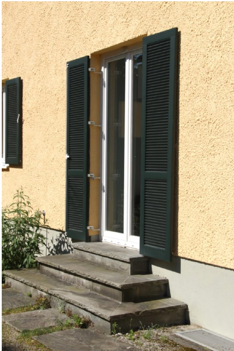
ABBILDUNG 49: HÖHERGESETZTER HAUSEINGANG (FOTO: GÜNTHERT 2015)
