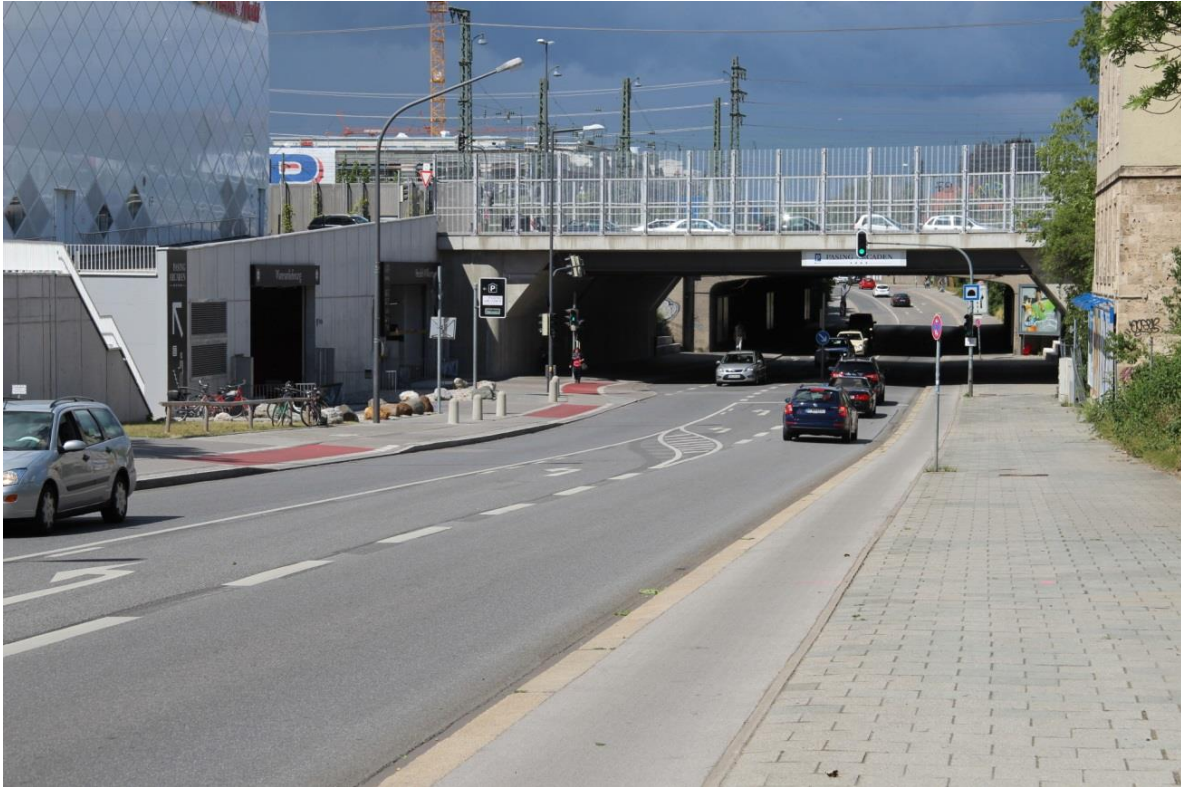
ABBILDUNG 21: UNTERFÜHRUNGSBAUWERK ALS TIEFPUNKT DER ENTWÄSSERUNG (FOTO: GÜNTHERT 2015)
