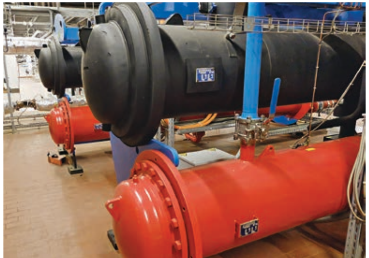
Abb. 26 Die solarthermische Kühlung steht in Konkurrenz zu Systemen mit konventionell oder solarelektrisch angetriebenen Kompressionskältemaschinen. Links: Absorptionskältemaschine Quelle: Kramer GmbH; rechts: Kompressionskältemaschine Quelle: Gerd Hirn, BINE Informationsdienst
