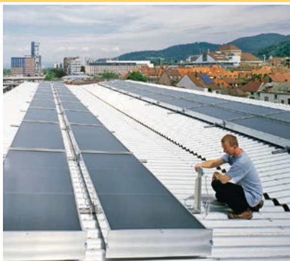
Abb. 3 Seit 2001 in Betrieb: Solar betriebene offene, sorptiv gestützte Klimatisierung (SGK) von Seminarräumen der IHK Südlicher Oberrhein, Freiburg. Die Regeneration des Entfeuchtungsrotors wird direkt durch ein 100 m 2 Luftkollektorfeld betrieben, das kostengünstig auf dem Gebäudedach installiert wurde. Quelle: Fraunhofer ISE
