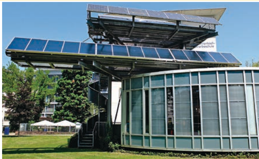
Abb. 12 Solare Kühlung im Rahmen der SolCoolSys-Feldtests an der Richard-Fehrenbach-Gewerbeschule in Freiburg. Links: Adsorptionskältemaschine und Hydraulikgruppe; rechts: Kollektorfeld. Quelle: Fraunhofer ISE
