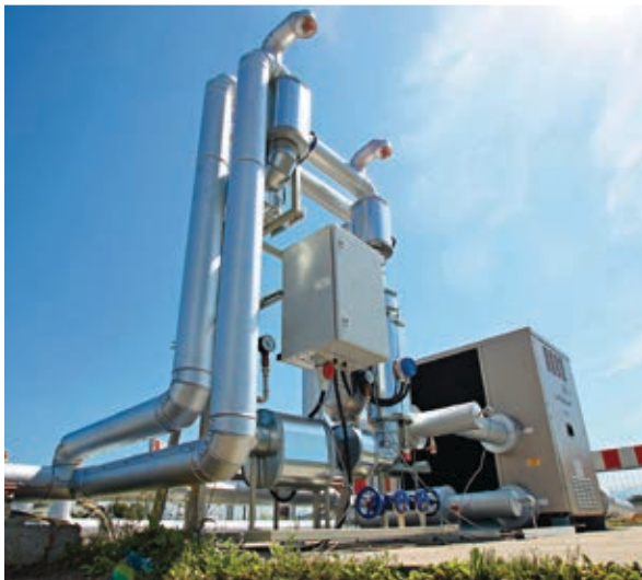
Abb. 26 Die solarthermische Kühlung steht in Konkurrenz zu Systemen mit konventionell oder solarelektrisch angetriebenen Kompressionskältemaschinen. Links: Absorptionskältemaschine Quelle: Kramer GmbH; rechts: Kompressionskältemaschine Quelle: Gerd Hirn, BINE Informationsdienst
